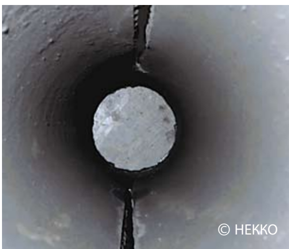
Труба, разрезанная Пластическим Перфоратором (вид изнутри)
